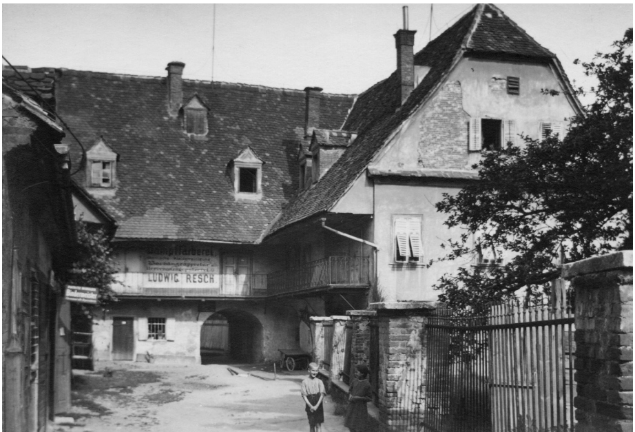
Adolf-Kolping-Gasse: Castellhof (Nr. 14, Abbruch 2010).
